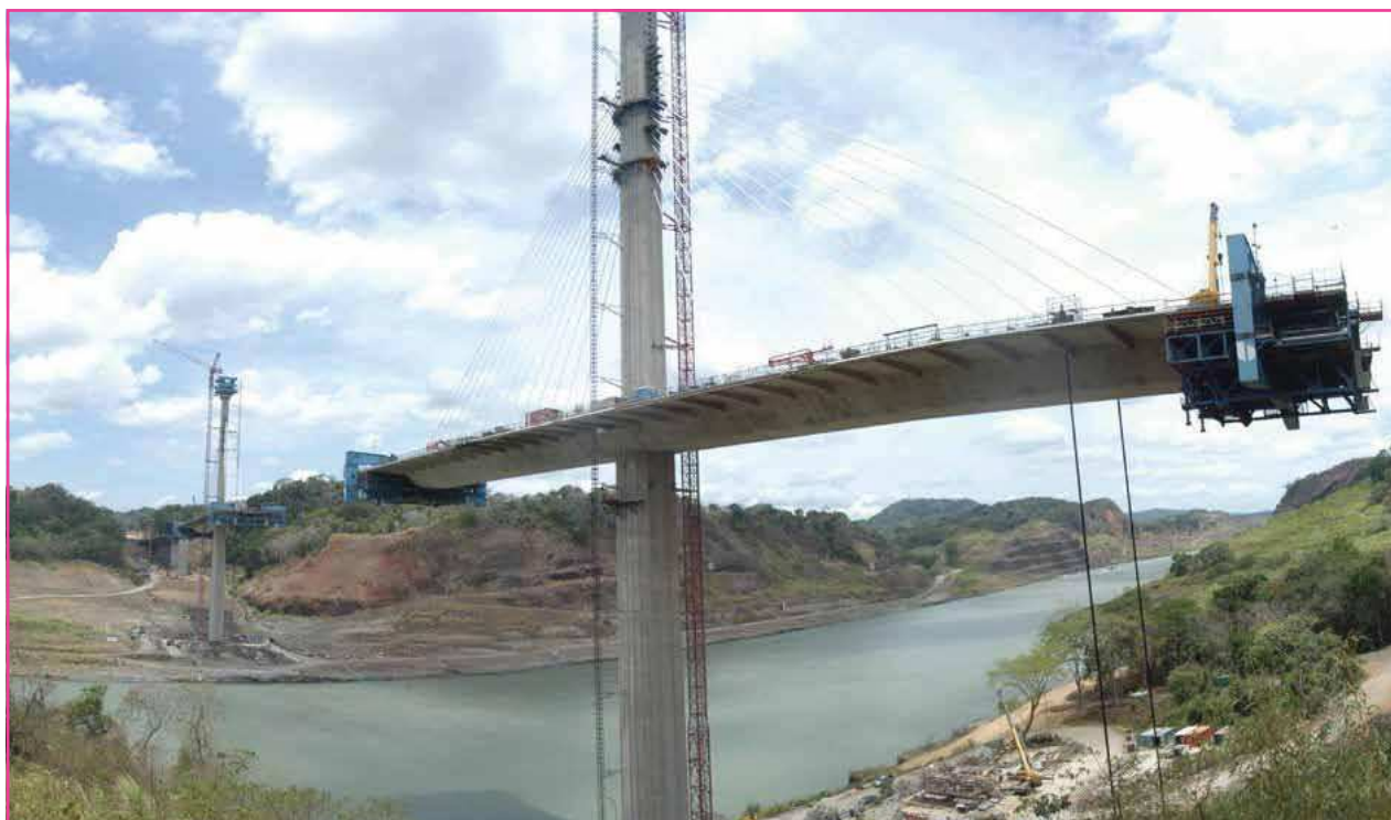
Réalisation du "Second Bridge over the Panama Canal -République of Panama" placées avec des équipements hydrauliques EUROPRESS a fournis les éléments hydrauliques qui soutiennent les segments pour la réalisation de la charpente du pont (Panama, juillet 2003)
