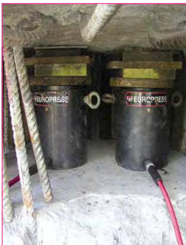
Réalisation du "Second Bridge over the Panama Canal -République of Panama" placées avec des équipements hydrauliques EUROPRESS a fournis les éléments hydrauliques qui soutiennent les segments pour la réalisation de la charpente du pont (Panama, juillet 2003)
