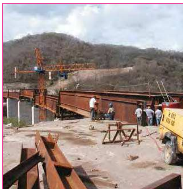
Construction du "Sistema de Transporte de la Región Central de Venezuela, Primera Etapa Caracas Tuy- Medio" grâce à la réalisation de viaducs ferroviaires avec des charpentes métalliques placées grâce à des équipements hydrauliques EUROPRESS (Caracas, Venezuela juin 2003)
